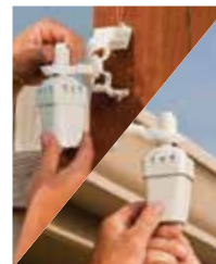
Установить датчик, воспользовавшись монтажным кронштейном.
